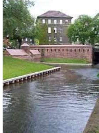
Rest der Befestigungsanlagen der Festung Spandau: Batardeau zur Regulierung des Wasserstandes im Festungsgraben
